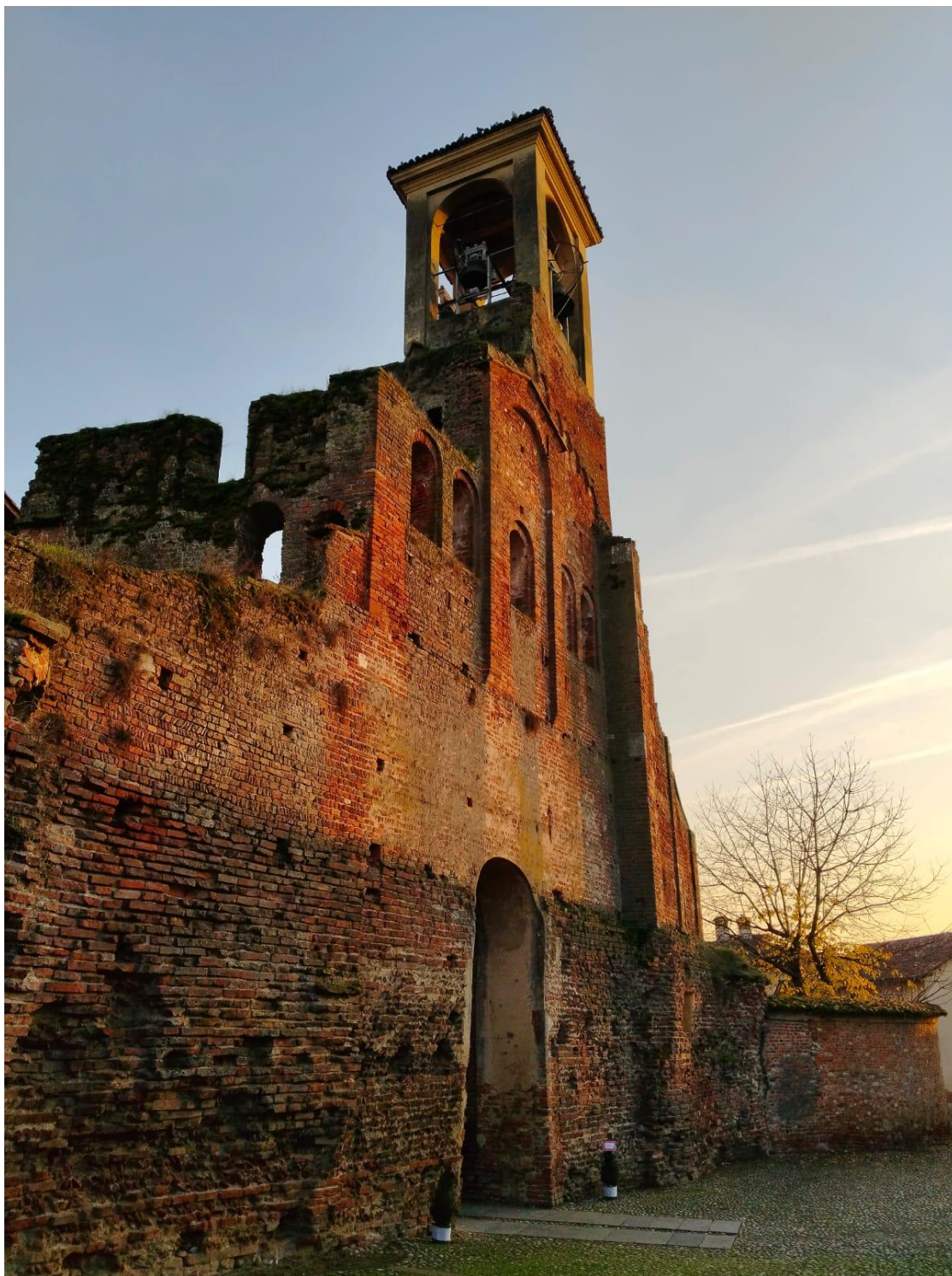
Figure 6. Lomello. Facade, Basilica of Santa Maria Maggiore
